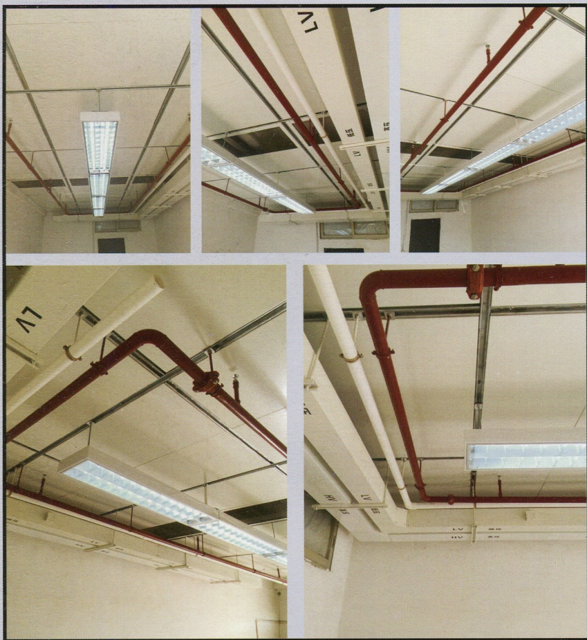
數據中心U槽天花安裝
